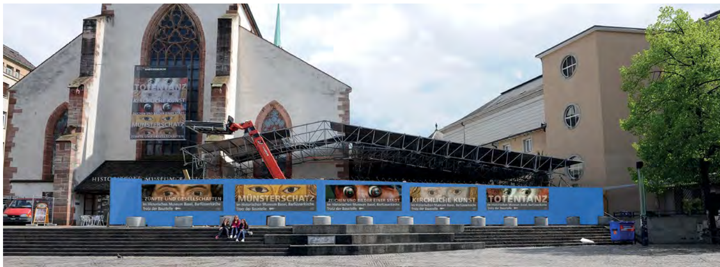
Mit einer aufwendigen Baumaßnahme wurde von April bis Oktober 2009 das Flachdach über dem Sonderausstellungsraum des HMB saniert und die Pflasterung auf der Südseite des Museums erneuert. Damit ist die Gefahr von Wasserschäden in den Museumsräumen beseitigt.
