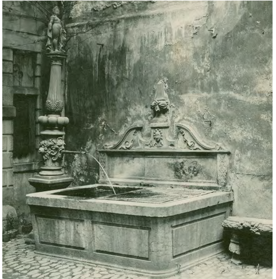
Abb. 17 Ceresbrunnen im vorderen Hof des Zerkindenhofs, Nadelberg 10. Aufnahme Anf. 20. Jh.
